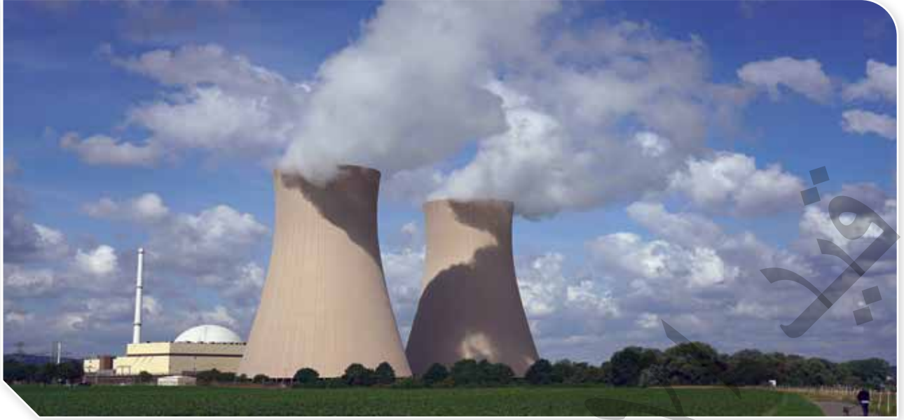
الشكل (14): أبراج التبريد يتصاعد منها بخار الماء.
