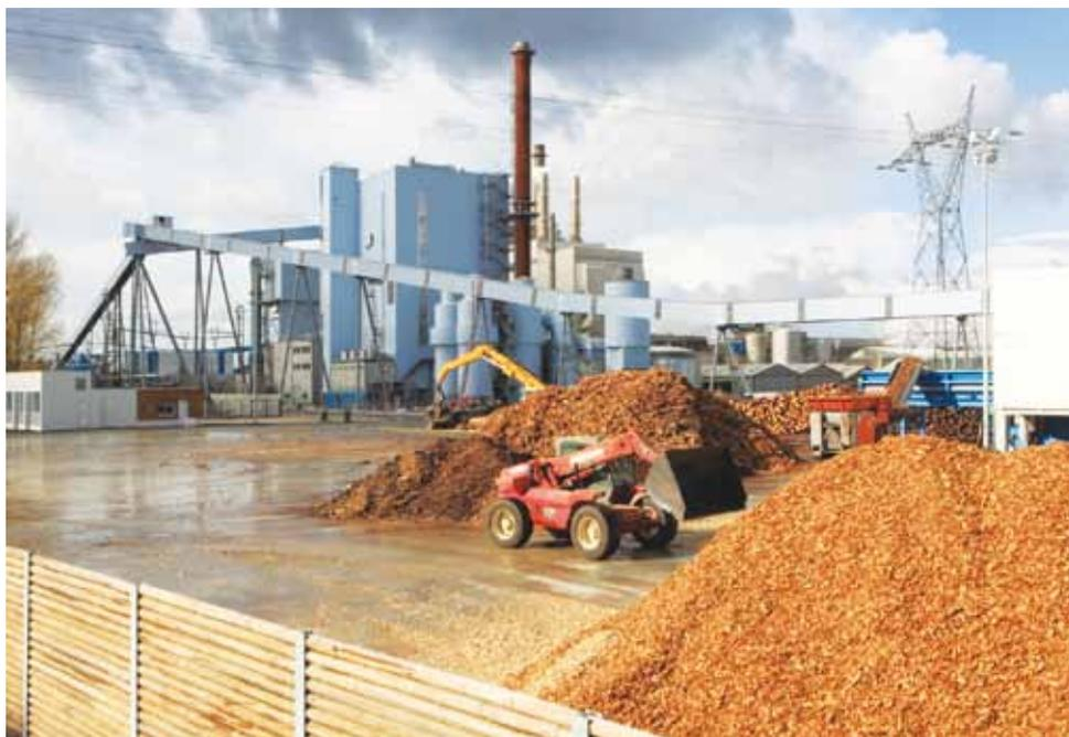
الشكل رقم (٢-١٩): محطة توليد الطاقة الكهربائية باستخدام الوقود الحيوي.
